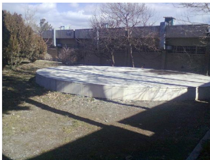
شکل ۱- مراحل طراحی و ساخت سکو برای نصب آلاچیق
