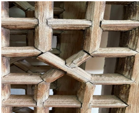
شکل ۱- نمونه سازه گره‌چینی طراحی شده
